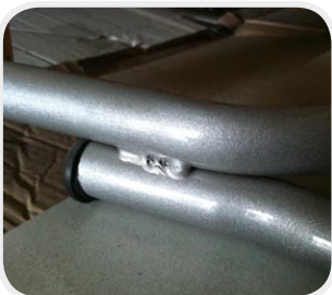
Soudure de renfort
