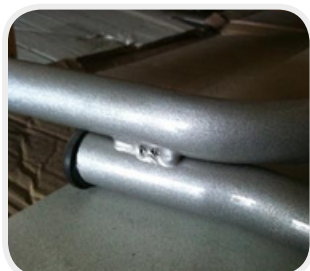
Soudure de renfort
